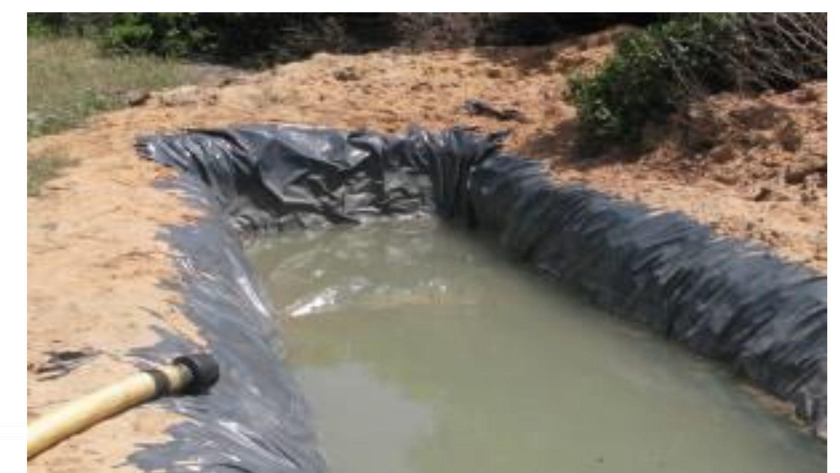
Figure 3. Bassin de récupération
